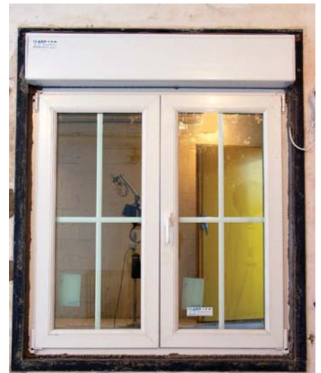
Afb. 2 Om een goede isolatie te bereiken, is het noodzakelijk om ook de rolluikkast zelf te behandelen.
